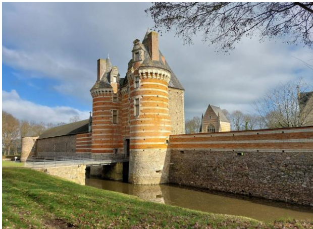
Château de Mortiercrolles (53) - Création de nouveaux circuits de visite
